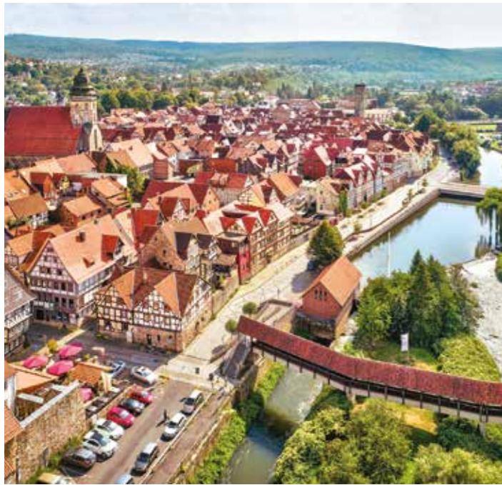
◀ HANN. MÜNDEN: Fulda mit Mühlenbrücke und Kasseler Schlagd
